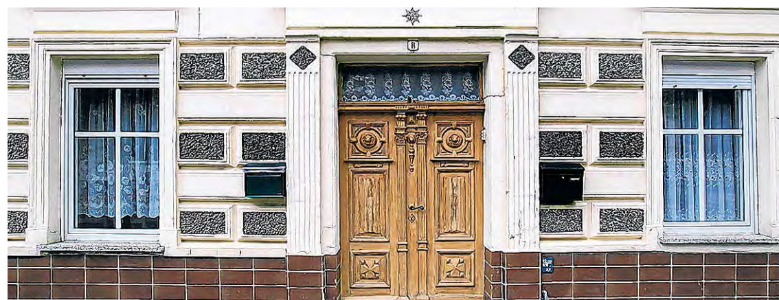
In der Stralsunder Straße 8 befindet sich eine zweiflügelige Gründerzeittür mit Oberlicht, entstanden wohl Ende des 19. Jahrhunderts, mit markanten kannelierten Stegen und je drei gerahmten Füllungen. Wie so viele andere steht auch dieses hübsche Haus in Altentreptow unter Denkmalschutz.
