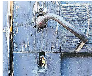
Spuren des jahrzehntelangen Gebrauchs: Unterbaustraße 18
