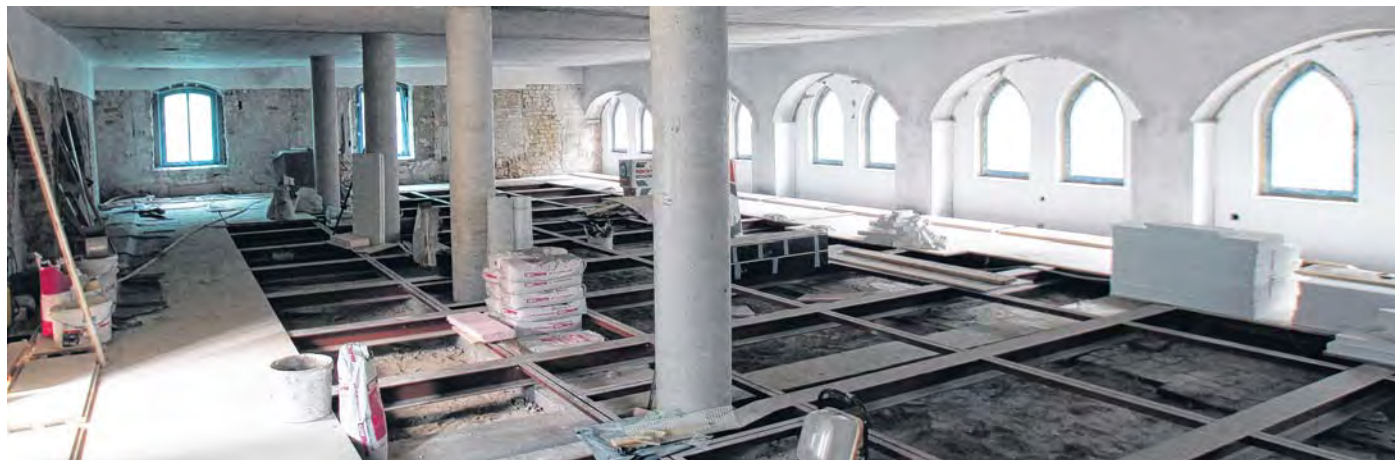
Im ersten Stock nimmt der Fußboden langsam Gestalt an, über den die Ausstellungsbesucher künftig wandeln werden.
