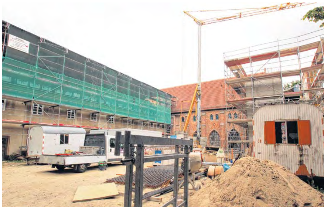
Im Innenhof des Klosters drängt sich alles auf engstem Raum - eine logistische Herausforderung. Die Fassade des Gebäudes der Kirchenkreisverwaltung Stargard (links) wird ebenfalls saniert.
