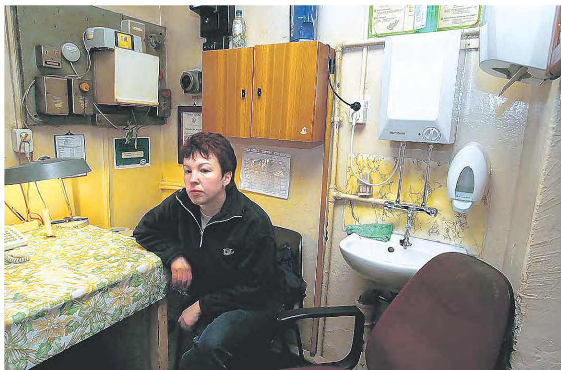
Andrea Schubert in der Schaltzentrale: Waschbecken und Boiler passen nicht so recht ins „Museumsbild“.
